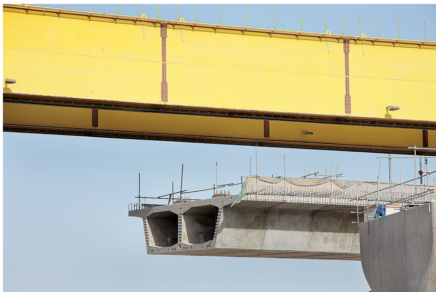
FIGURA 9 Impalcato precompresso da ponte.
